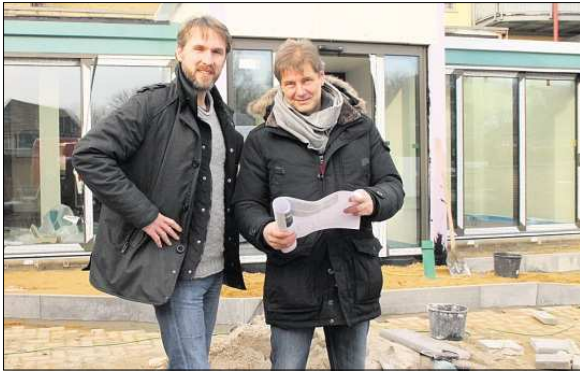
Arne Kinsky und Architekt Frank Böckenholt inspizieren die Baustelle. Fotos: Wauer
